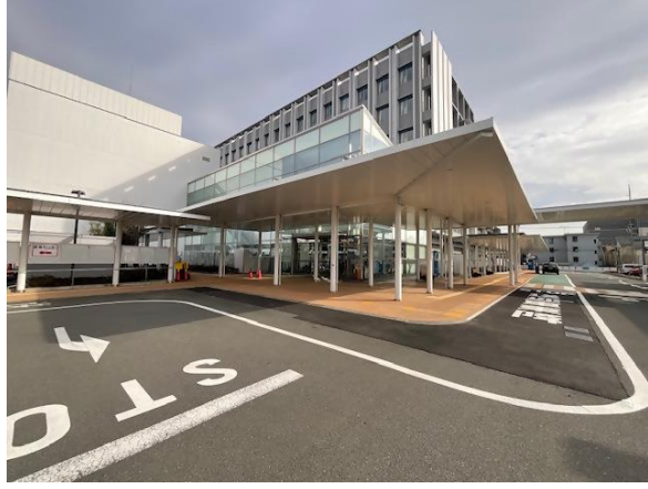
正面玄関防水板設置前
