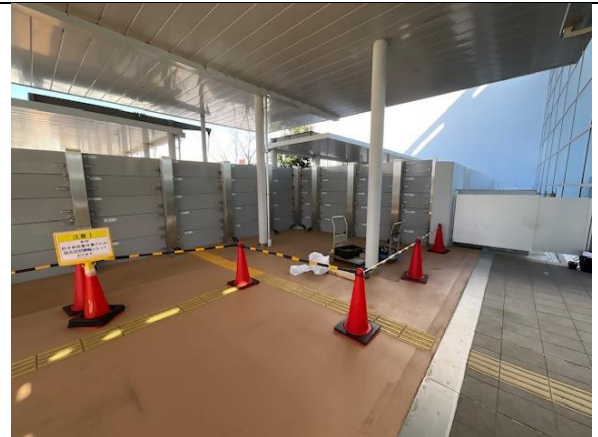
正面玄関防水板設置後(内側②)
