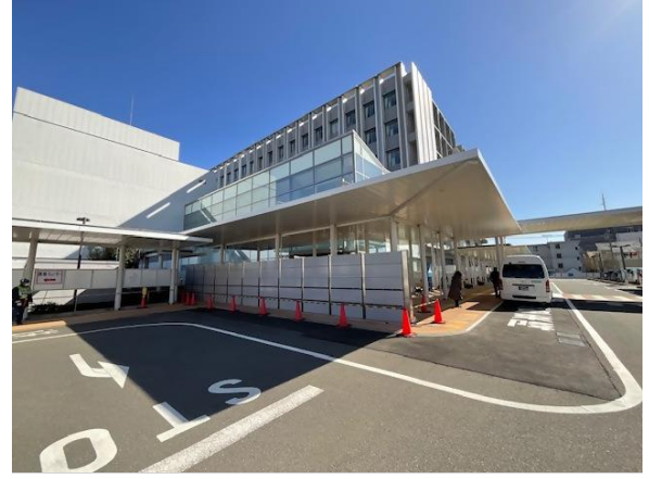
正面玄関防水板設置後①
