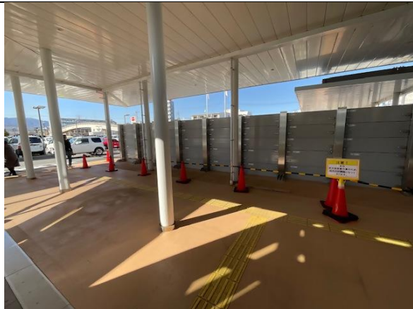
正面玄関防水板設置後(内側①)
