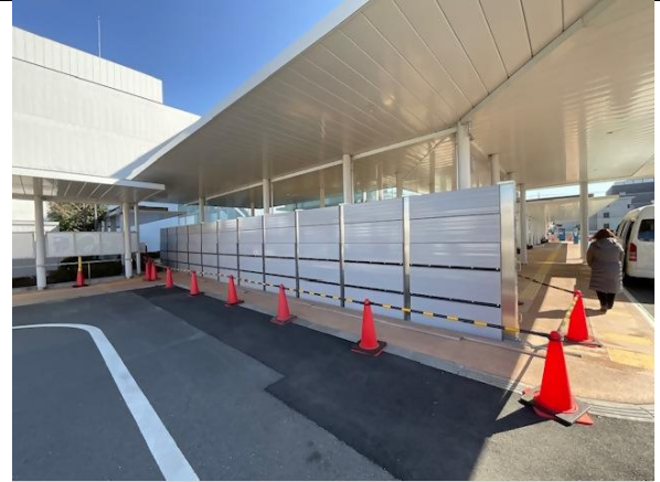
正面玄関防水板設置後③
