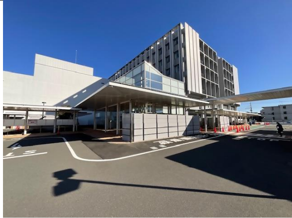
正面玄関防水板設置後②
